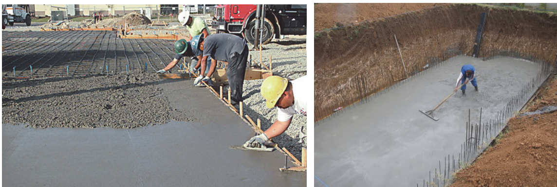
Сл. 2.33.а) Завршна обработка на бетон со рачен алат
