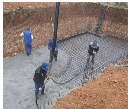
Сл. 5.8. Вградување на мрежаста арматура
