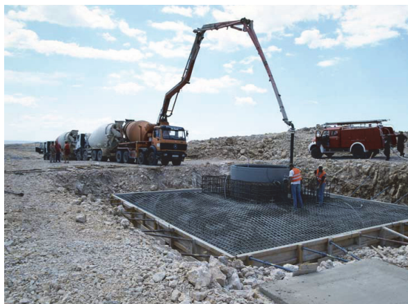
Сл. 2.24. Мобилна пумпа за бетон
