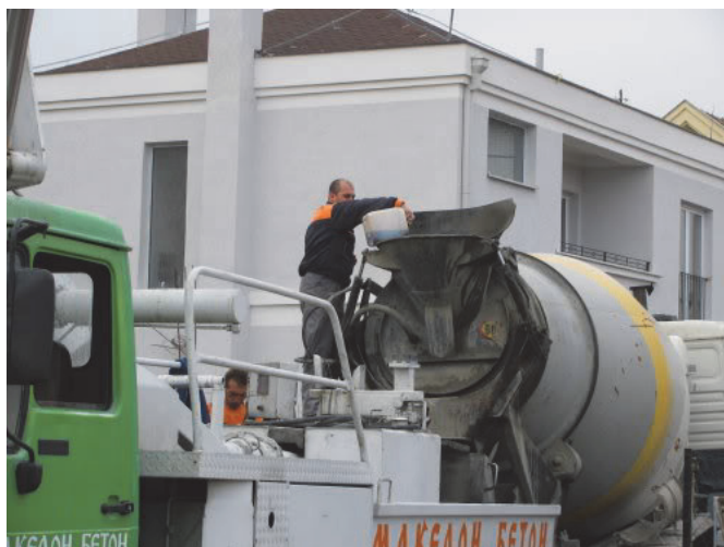
Сл. 1.30. Додавање на адитиви во бетонската маса непосредно пред бетонирањето
