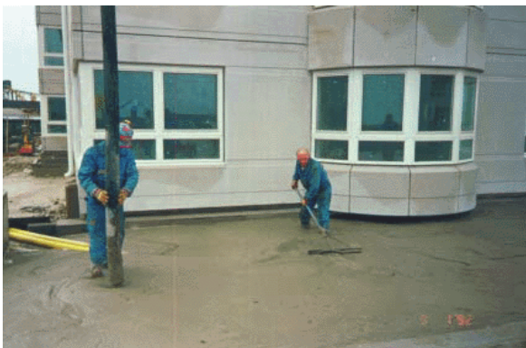
Сл. 3.14. Вградување на лесен бетон
